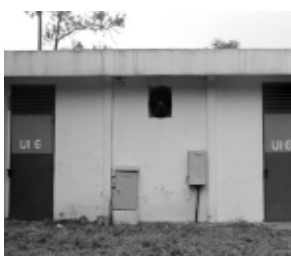
Gambar 1.4 Gardu Beton.
